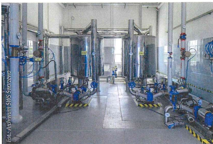
FOT. 2 Zbiorniki tłuszczu wraz z pompami i armaturą
