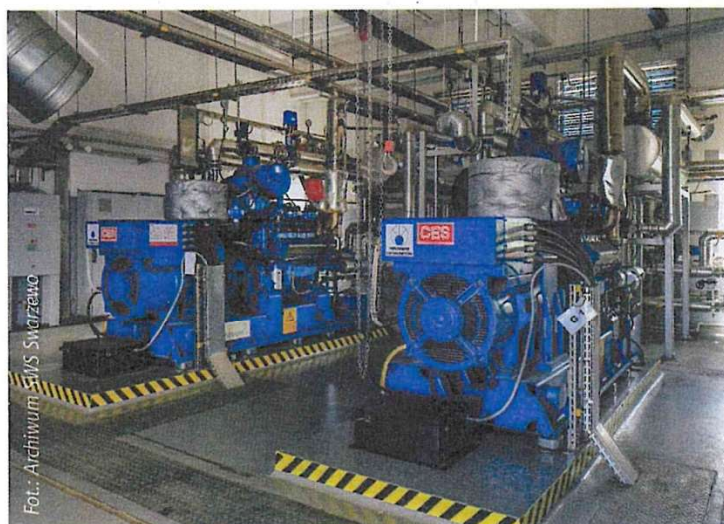
FOT. 3 Kogeneratory z osprzętem i armaturą cieplownicą wraz z oznaczeniem stref niebezpiecznych
